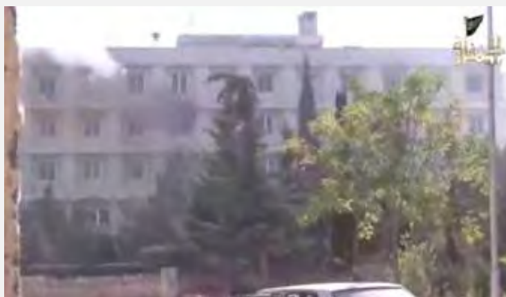
RPG tiré sur un bâtiment administratif à Alep. Un épais nuage de fumée peut être vu sortant du quatrième étage (Youtube.com)
