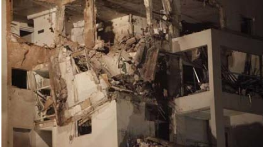
Appartement détruit par une roquette à Rishon-le-Zion (Alster/Flash 90)
